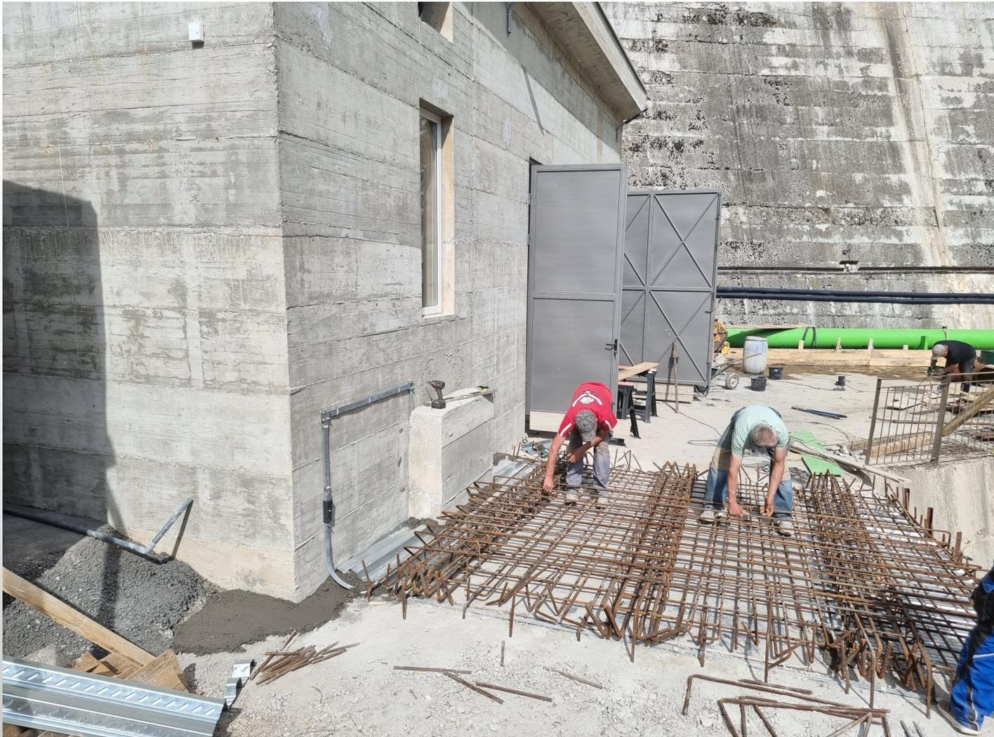
Deasupra bazinului de linistire a fost executat un capac din beton armat
