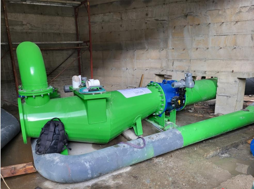
Deoarece turbina a fost racordata la circuitul golirii de fund, pentru protejarea turbinei a fost instalat un gratar cu autocuratare pe circuitul de aductiune al turbinei. Gratarul este prevazut cu senzori diferentiali de presiune, iar circuitul de spalare se activeaza atunci cand diferenta de presiune creste, gratarul fiind colmatat
