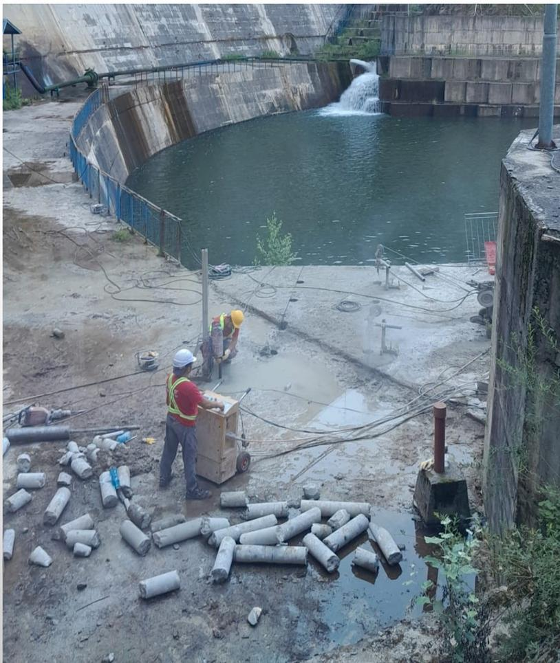
Pentru decuparea betonului au fost realizate carote atat orizontale cat si verticale cu ajutorul unor instalatii speciale dupa care s-a folosit un lant diamantat pentru decuparea blocurilor de beton
