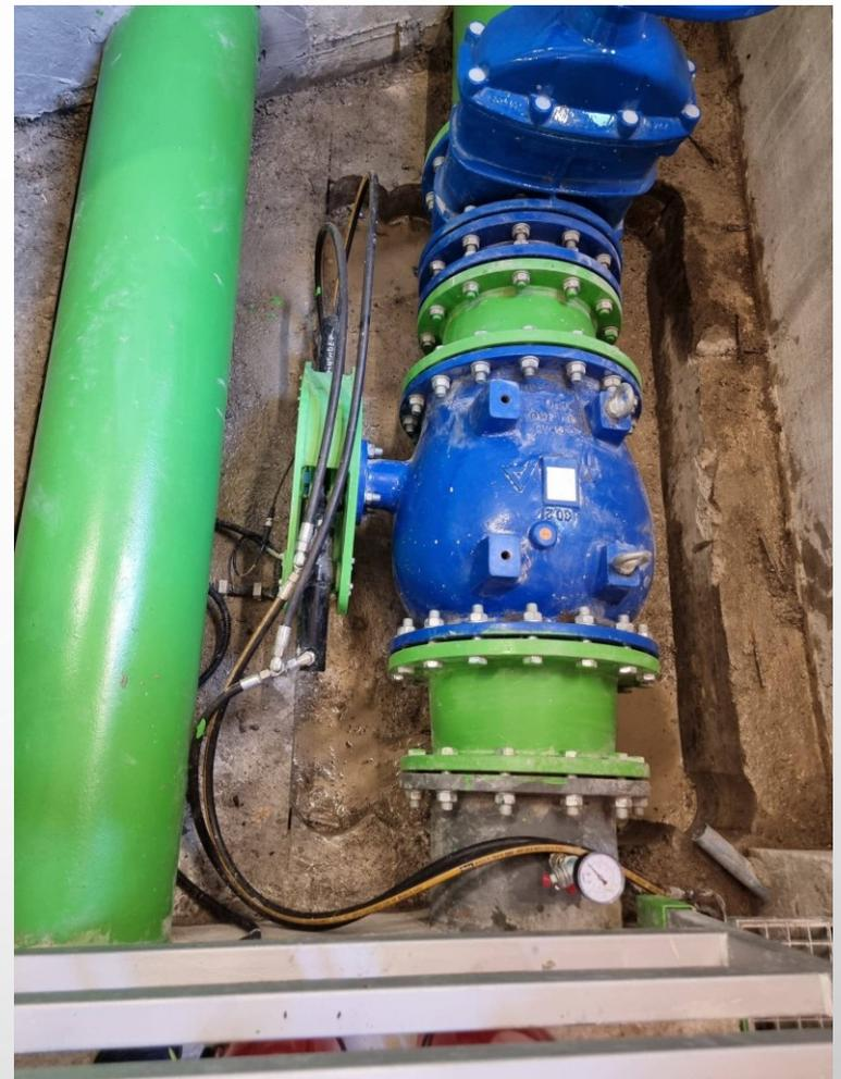
Pentru asigurarea debitului de servitute atunci cand turbina nu functioneaza s-a prevazut o vana Johnson DN350 cu actionare hidraulica de la GUP-ul turbinei.
